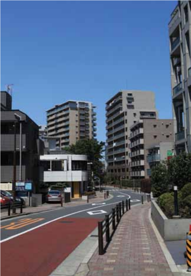
串聯再開發事業及重建事業間之東西道路整備為10M(車道6M+二側步道2M)寬敞舒適 （攝影：林雲騰）
