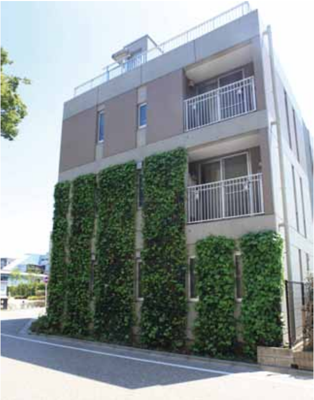
透過屋頂綠化及豎面綠化(C街區C棟)落實生態節能（攝影：林雲鵬）
